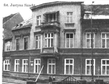
W tym budynku doszło do wybuchu butli z gazem. W chwili obecnej prowadzone są już prace remontowe
