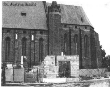
Początek prac budowlanych
