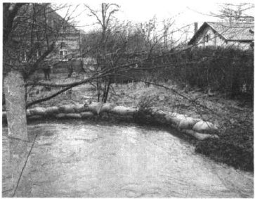
Zabezpieczone przed zalaniem przydomowe ogródki
