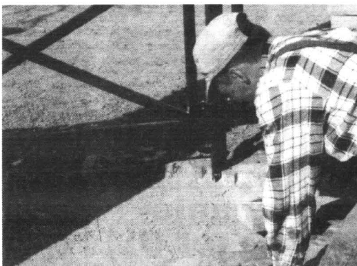
Kolejne elementy układu się, kładąc na już ułożonej posadzce
