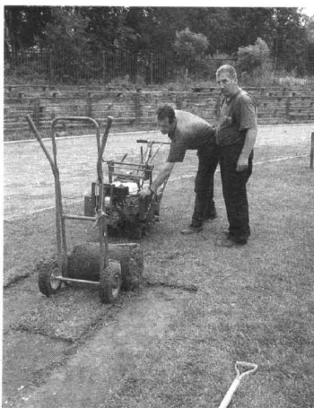
Pracownicy KCSiR przy renowacji płyty głównej
