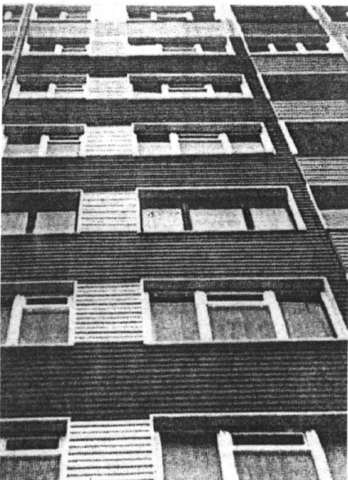
Coraz częściej sidingiem otulane są także budynki wielopiętrowe. Najlepiej do tego celu nadaje się otulina metalowa
