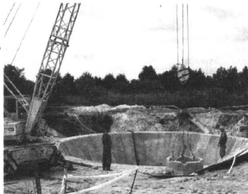
Modernizacja oczyszczalni - uciążliwa ale potrzebna
