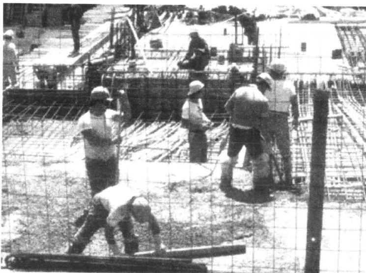
Z uwagi na łatwość i szybkość wykonania, najczęściej do budowy fundamentów stosuje się beton zbrojony wkładkami stalowymi
