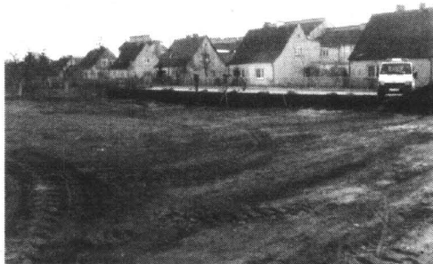
Przy ulicy Żeromskiego rozpoczęto już prace. Już niebawem będą tam boiska
