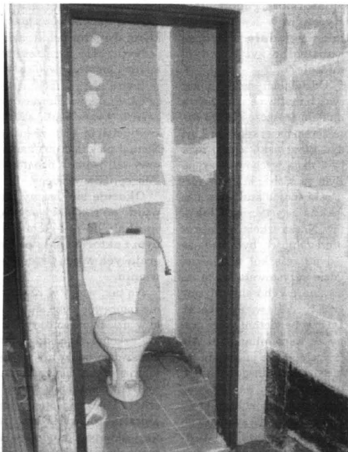
Do ubikacji prowadzi kilkunastometrowy, nieogrzewany korytarz
