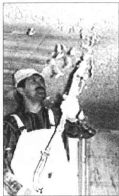
Prace tynkarskie można wykonywać również zimą
