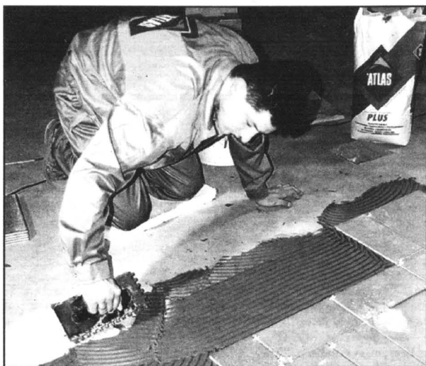
Odpowiednia zaprawa klejąca zależy od rodzaju podłoża
