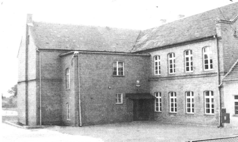
W budynku dzisiejszej Szkoły Podstawowej nr 3 przy ul. Malborskiej w 1945 roku utworzono Szkołę Powszechną nr 3. Szkoły nr 1 i 2 początkowo mieściły się przy ul. Środkowej (dzisiejsza Batalionów Chłopskich).
