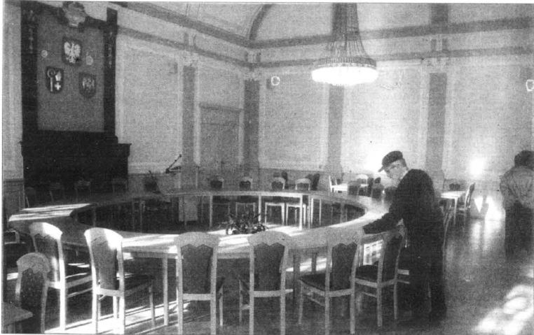
Remont sali obrad i głównego holu Urzędu Miejskiego kosztował ok. 800 tys. zł. Na zdjęciu: Józef Sliwiński, pracownik Urzędu.
