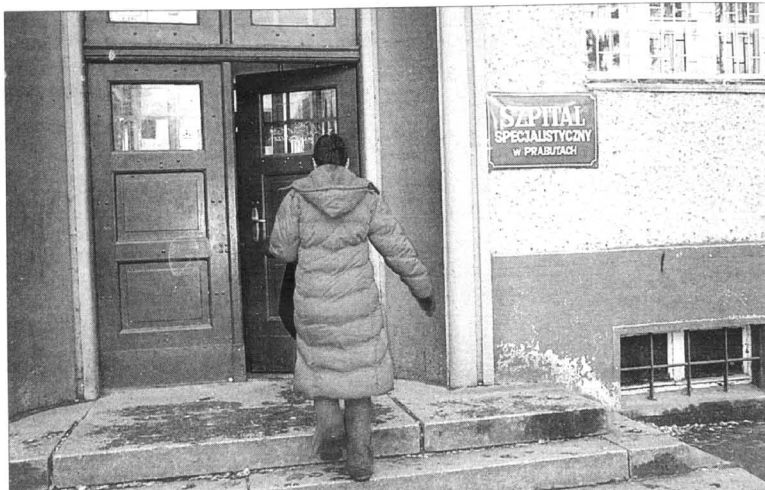
Dyrekcja oraz samorządowcy zachęcają do zagospodarowania pustostanów znajdujących się na terenie prabuckiego szpitala. Na zdjęciu: były budynek administracyjny.
