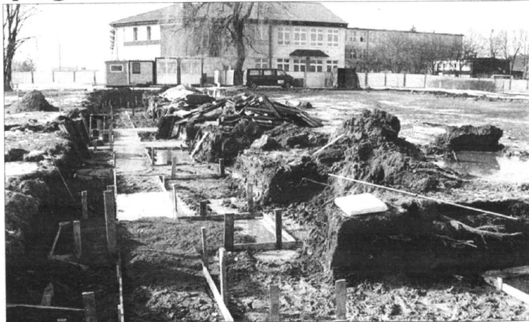
Trwa budowa hali widowiskowo-sportowej. Utrudnieniem jest pogoda. Śnieg opóźnia prace. Termin realizacji - dziesięć miesięcy.
