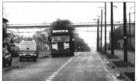
Przed budową wiaduktu i dróg dojazdowych władze miasta zmodernizowały ulice Południową i Łużycką.
