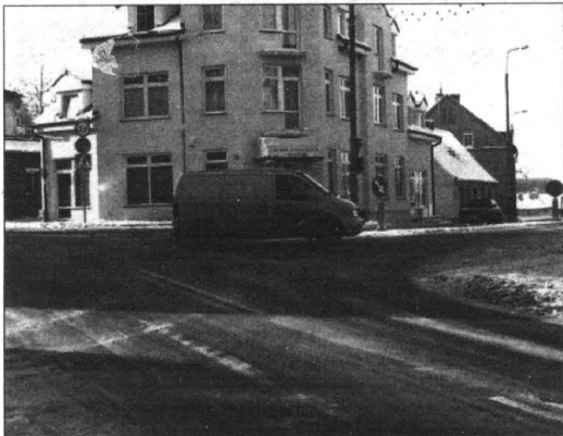
1,2 mln zł kosztowała modernizacja skrzyżowania ulic Sztumskiej oraz Żwirki i Wigury.
