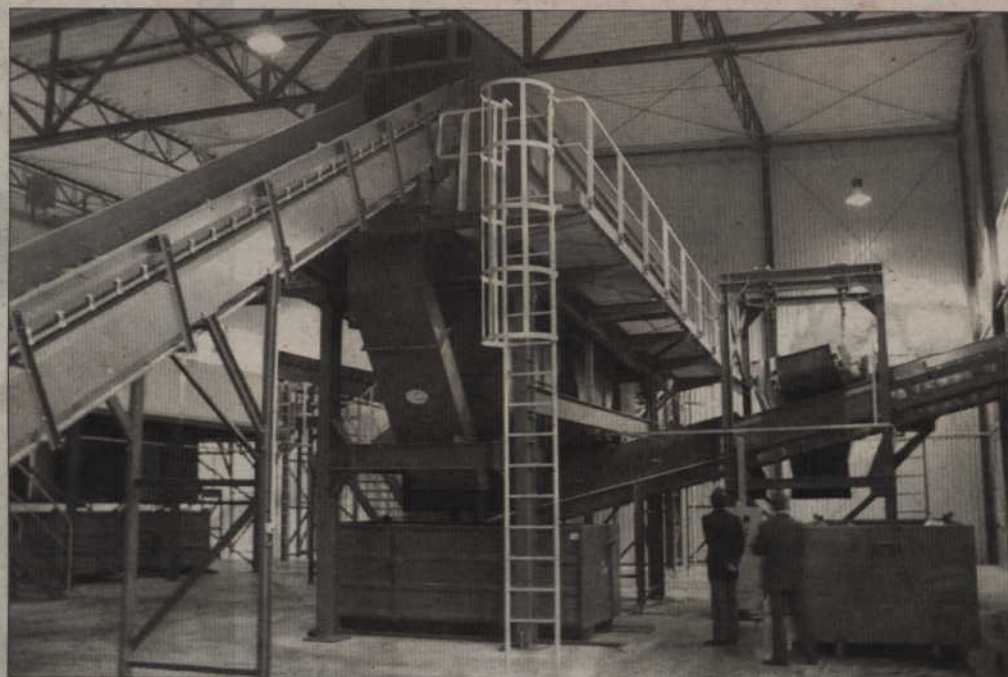
W powiecie kwidzyńskim rozpoczął się proces zamykania składowisk odpadów komunalnych, które nie spełniają wymogów ochrony środowiska. Obecnie śmieci trafiają do nowoczesnego zakładu w Gilwie Małej w gminie Kwidzyn. Fot. Mirosław Wiśniewski
