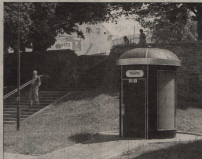
Obok teatru znajduje się nowoczesna i higieniczna publiczna ubikacja dla mieszkańców i turystów. Fot. Mirosław Wiśniewski
