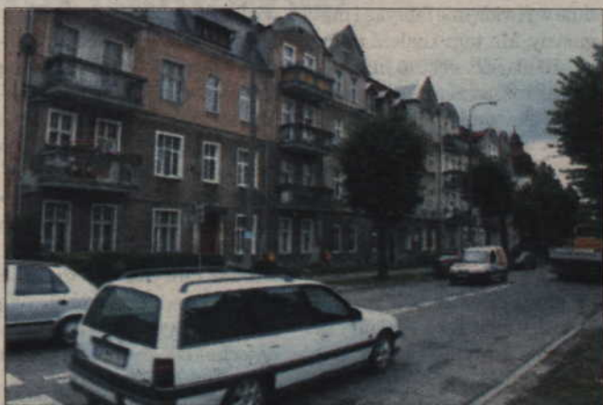
Ulica Wiślana. Stoją przy niej wiekowe kamienice, które narażane będą na wstrząsy i pęknięcia.
