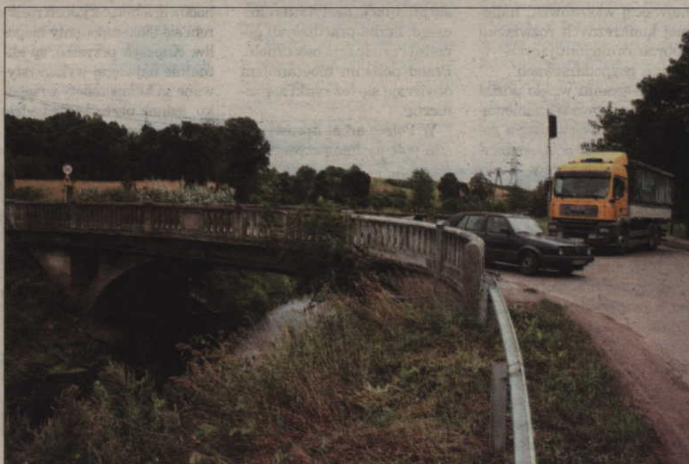
Zmierzając ulicą Furmańską, trzeba pokonać mostek. Dla uporządkowania ruchu wprowadzono na czas objazdu sygnalizację świetlną.
