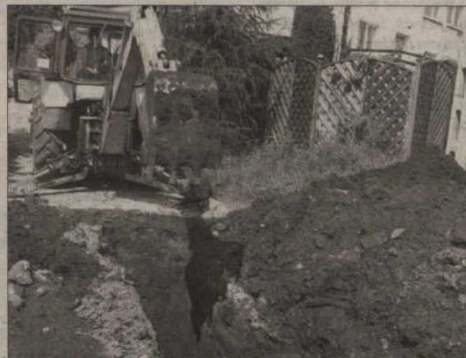
Trwa budowa kanalizacji sanitarnej na osiedlach Chodkiewicza i Łąkowa w Prabutach. Prace zakończą się w grudniu.
