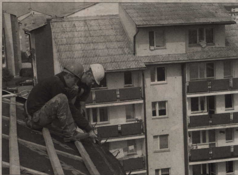
Rozpoczęło się usuwanie eternitowych dachów z budynków Spółdzielni Mieszkaniowej „Pomezania”. Na zdjęciu: Jacek Janowski i Maciej Montowski.
