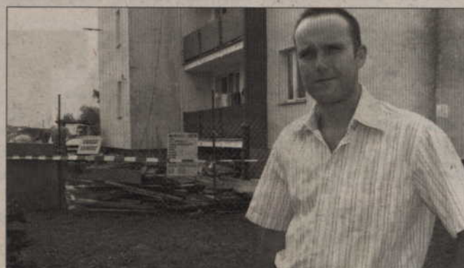
- Nasza firma wymieni dach na co najmniej czterech blokach przy ul. Wschodniej i Krańcowej - mówi Rafał Łysakowski, kierownik budowy.
