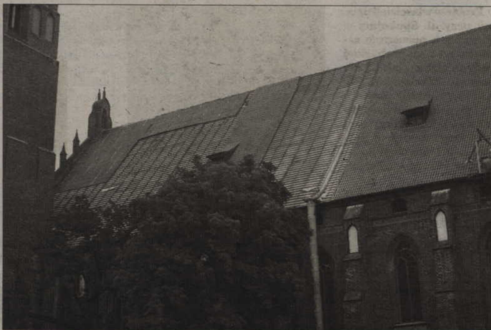
Trwa remont dachu na kwidzyńskiej katedrze. Wymiana pokrycia dachu była niezbędna - był w tak złym stanie, że zagrażało to zgromadzonym w środku cennym pamiątkom.
