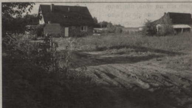
Właściciele działek na ul. Spokojnej w Prabutach nie mają wody, prądu ani kanalizacji. Inwestycja już ruszyła. Według zapewnień gminy, pod koniec października ma być już na tym terenie woda.
