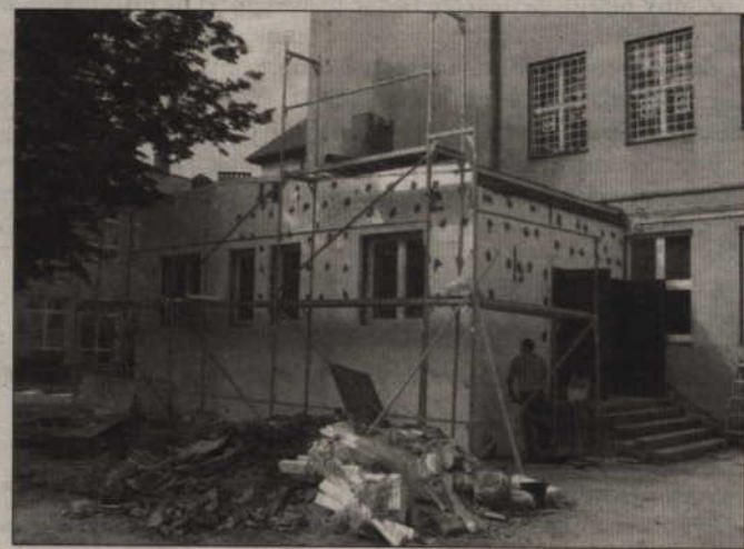
Obiekt nie spełniał wymogów sanepidu. Konieczna była modernizacja. Remont trwał od czerwca do września. Zdjęcia: Archiwum
