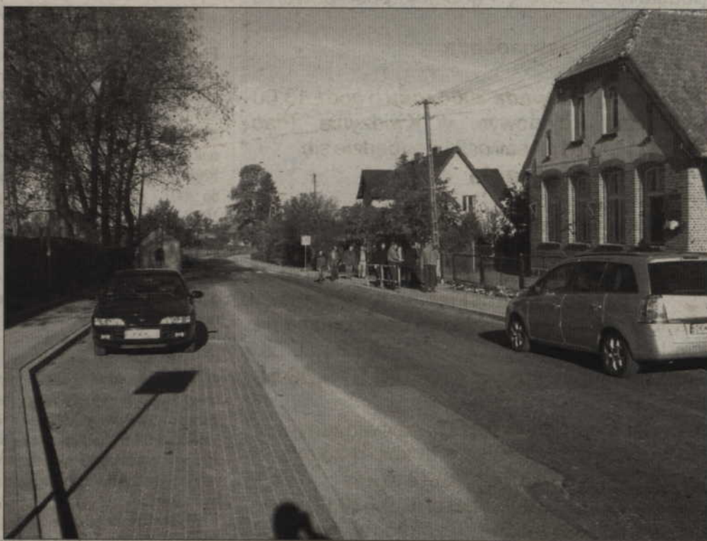
Nowa zatoka autobusowa, wyremontowana nawierzchnia, nowy chodnik i barierki poprawiły bezpieczeństwo dzieci uczęszczających do szkoły Podstawowej w Straszewie.
