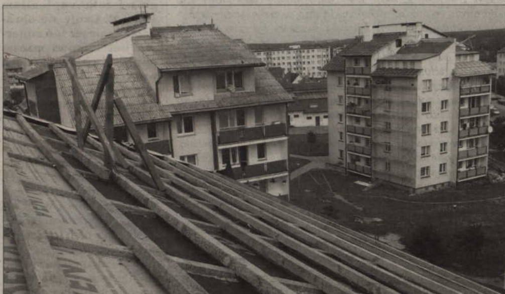
Największą ilość eternitu do utylizacji zgłosiła Spółdzielnia Mieszkaniowa „Pomezania”. Łącznie usuniętych zostanie ok. 7,8 tys. m. kw. powierzchni dachów zawierających azbest.
