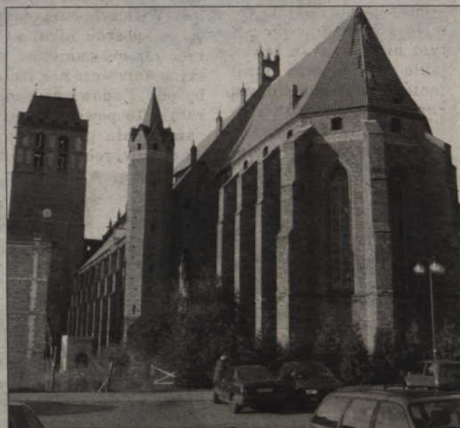
Dobiega końca kompleksowy remont dachu na kwidzyńskiej katedrze. Fot. Mirosław Wiśniewski
