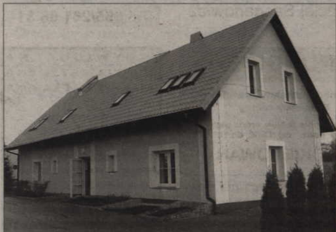
W nowym budynku przy ul. Malborskiej zamieszkało 14 wychowanków z Domu Dziecka.
