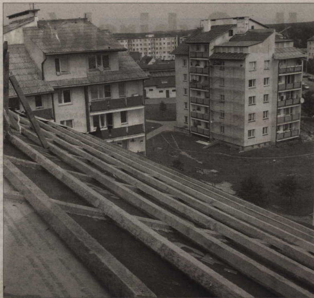
Jeśli ktoś chce pozbyć się azbestowego dachu, może liczyć na dofinansowanie ze specjalnego powiatowego funduszu.
