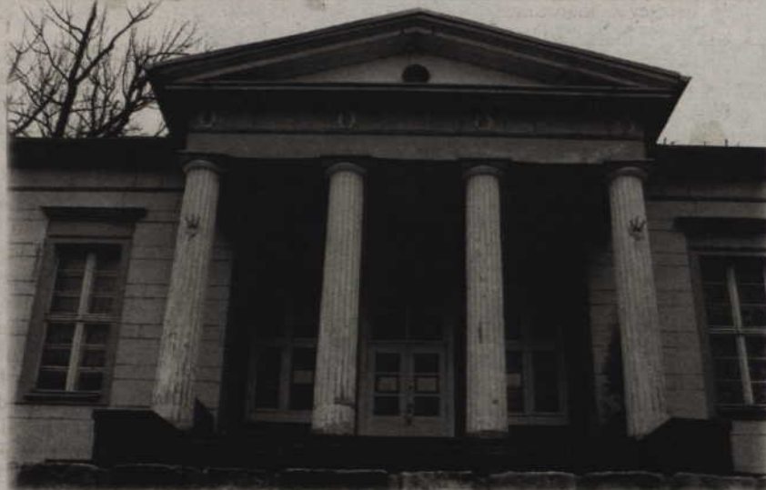
Samorząd Kwidzyna zamierza wyremontować ten zabytkowy budynek przy ul. Warszawskiej. Zostanie on zamieniony w pałac ślubów. Będzie można tam też wymienić dowód osobisty i załatwić sprawę dotyczącą ewidencji ludności i obrony cywilnej.
