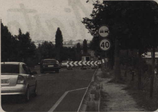
Remont wiaduktu na ul. Jagielly potrwa do końca października.
