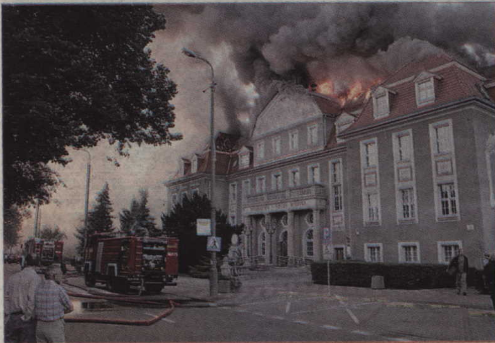
Ogień zniszczył pomieszczenia biurowe na poddaszu, wraz z całym wyposażeniem. Na szczęście nikt nie doznał obrażeń.
