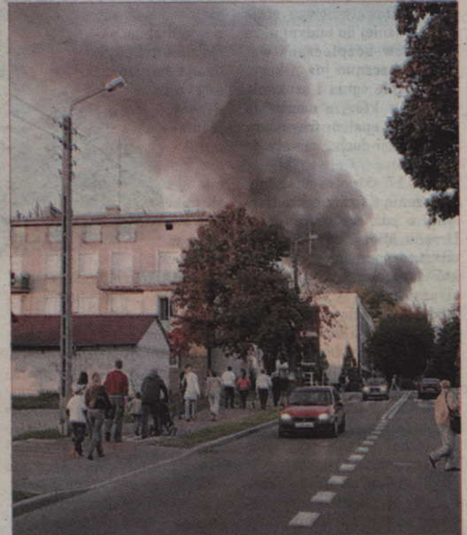
Dym z płonącego budynku unosił się wysoko nad miastem. Na zdjęciu: ulica Kopernika.
