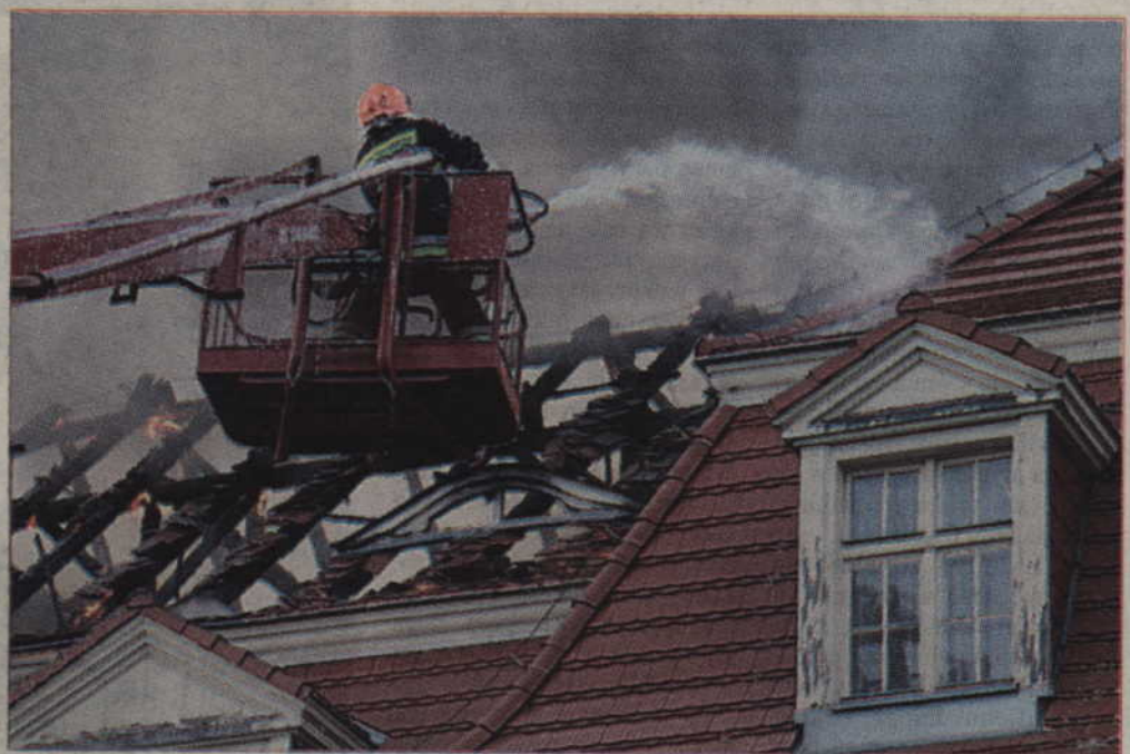
Dach zostanie zabezpieczony przed deszczem. Jak obliczono potrzebna będzie plandeka o pow. ok. 3 tys. m kw.
