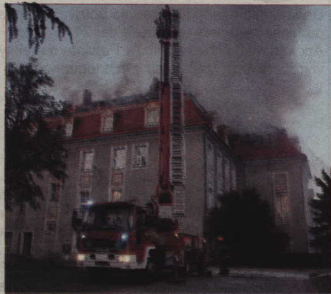
Do budynku nikt nie może wchodzić. Pracownicy zdążyli jeszcze wynieść stamtąd serwer, na którym znajdują się wszystkie dane miasta.
