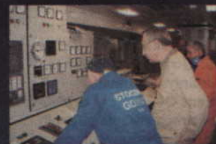
Próby morskie statku ostatni szlif przed sprzedażą kolejnego Ro-Ro samochodowca
