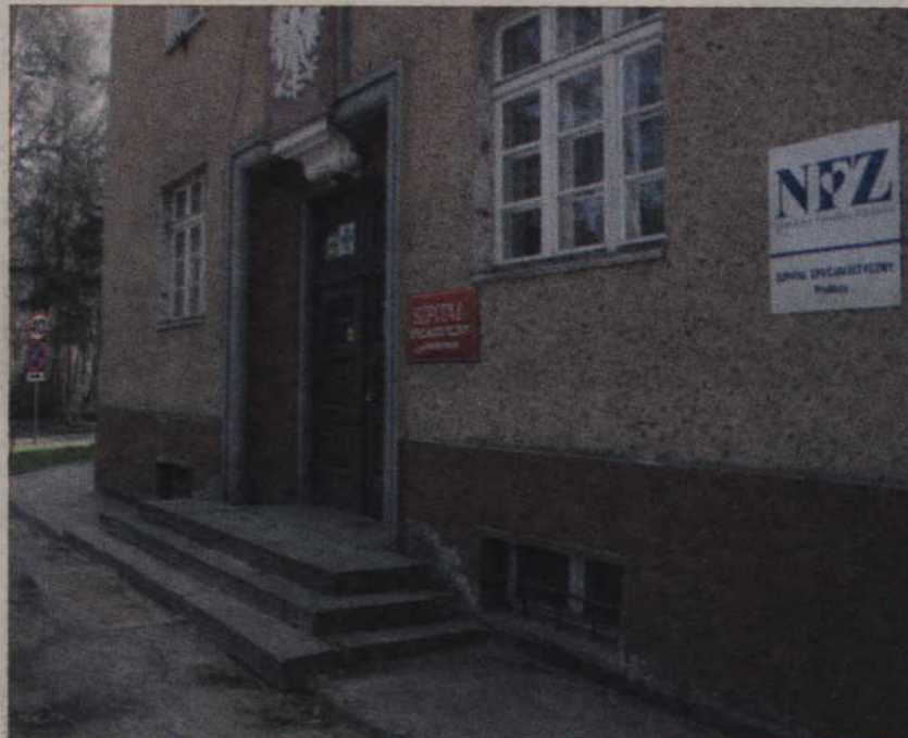
Do końca 2012 r. wszystkie placówki służby zdrowia muszą spełniać określone przez ministra zdrowia wymogi oraz parametry, dotyczące stanu technicznego i wyposażenia. Niektóre pomorskie szpitale będą miały z tym duży problem, np. Szpital Specjalistyczny w Prabutach (pow. kwidziński), który jest zadłużony na ok. 24 mln zł.
