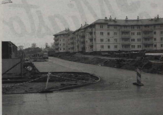
W tym roku zostanie dokończona budowa nowej ulicy na osiedlu Piastowskim. Połączy ona ulice Chrobrego i Krzywoustego.
