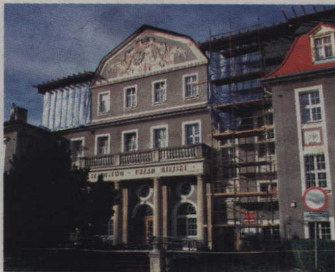
Podpisano umowę z kwidzyńską firmą na odbudowę dachu Urzędu Miejskiego. Dach został zniszczony w wyniku pożaru we wrześniu ubiegłego roku.
