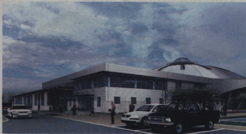
Budowa kompleksu sportowego przy ul. Wiejskiej ma kosztować ok. 50 mln zł. Hala pomieści ok. 1500 widzów.
