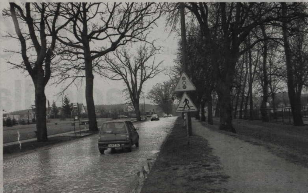
Fragmentem małej obwodnicy jest ul. Sportowa. Generalna Dyrekcja Dróg Krajowych i Autostrad zapowiada, że wykona modernizację nawierzchni.
