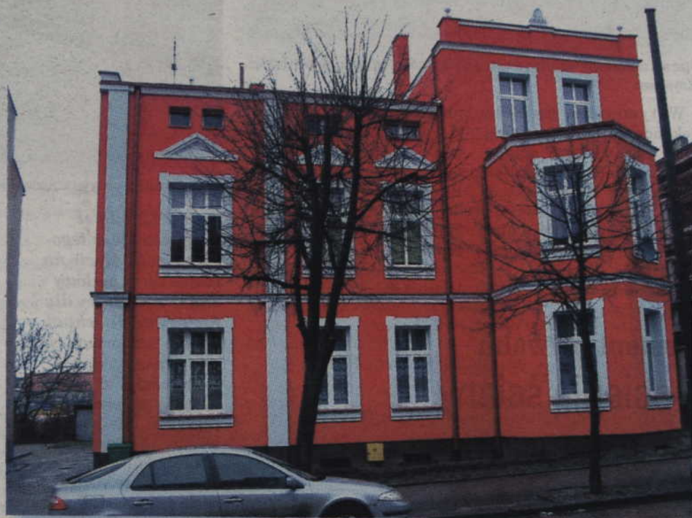
25 kamienic zostanie w tym roku wyremontowanych w mieście. Nowe elewacje pojawią się na 23 budynkach wspólnot oraz 2 kamienicach w całości należących do miasta.
