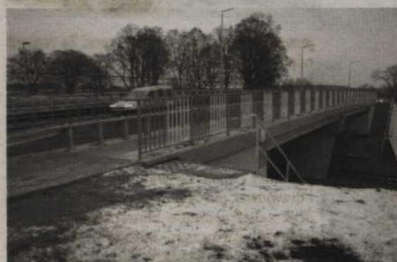
Nowy most na ulicy Południowej to gotowy już fragment obwodnicy.
