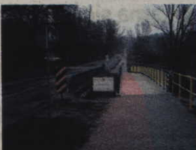
Ścieżka rowerowo - piesza i kładka przez rzekę Liwę w Górkach.
