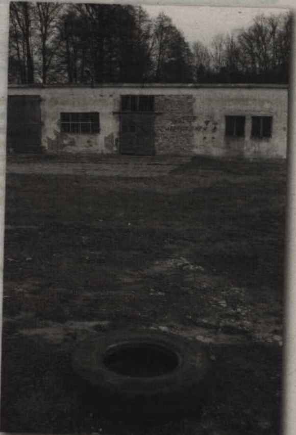
Tereny w Górkach czekają na budowę Kwidzińskiego Parku Przemysłowo-Technologicznego. To jedna z trzech najważniejszych inwestycji w powiecie kwidzińskim, które mają być finansowane ze środków unijnych. Wartość projektu szacowana jest na ok. 10 mln euro.
