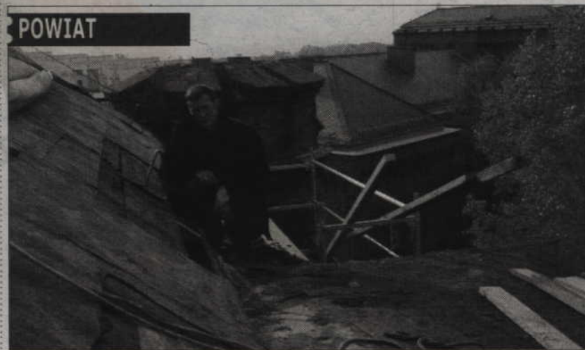
Remont budynku, w którym mieści się między innymi Urząd Gminy Kwidzyn, prowadzony jest od ubiegłego roku i nie zakłóca pracy mieszczącym się w nim instytucji.
