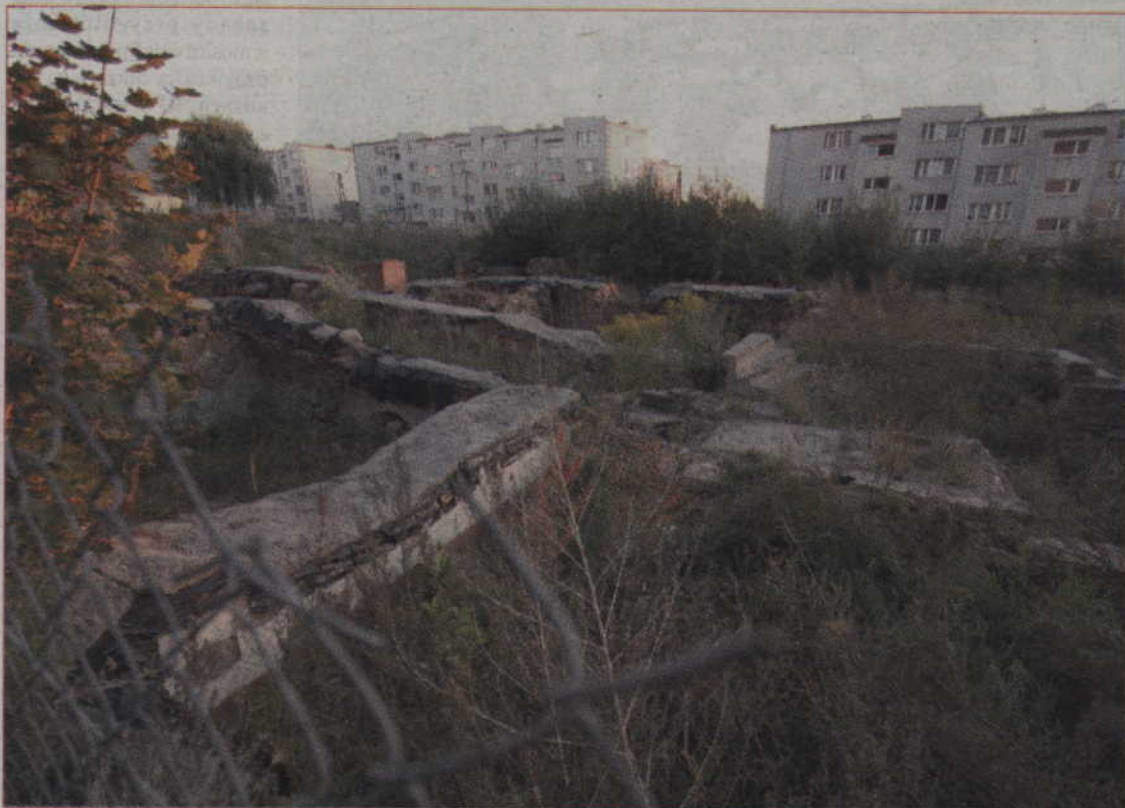
Odbudowa Starego Miasta rozpocznie się od ustabilizowania gruntu.
