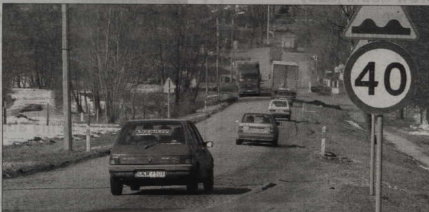
Miasto czeka jeszcze na budowę małej obwodnicy. Połączy ona w przyszłości drogę krajową z Kwidzyna do Grudziądza oraz wojewódzką z Kwidzyna do Prabut. Jej częścią ma być ulica Sportowa (fragment drogi krajowej nr 55), której nawierzchnia jest w fatalnym stanie.
