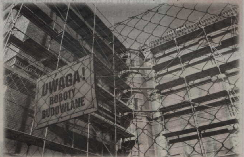
Wyremontowano już część dachu i wyczyszczono elewację pokoszarowego budynku przy ul. Kościuszki, w którym nową siedzibę ma mieć kwidzińskie starostwo. Prace powinny zakończyć się w marcu przyszłego roku.
