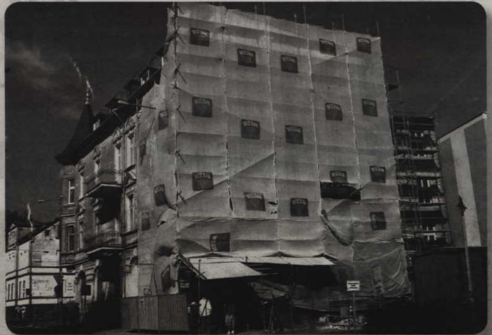
Trwa remont kamienic. Nowe elewacje pojawią się w tym roku na 28 budynkach.
