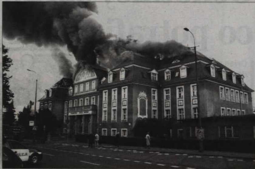
Remont budynku Urzędu Miasta ma się zakończyć do końca lutego. W pożarze, który wybuchł we wrześniu ubiegłego roku, spłonęły górne kondygnacje.
