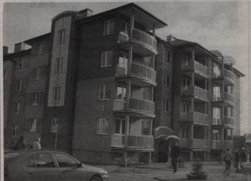
Nowy budynek Renawy przy ul. Bolesława Śmiałego 4.
