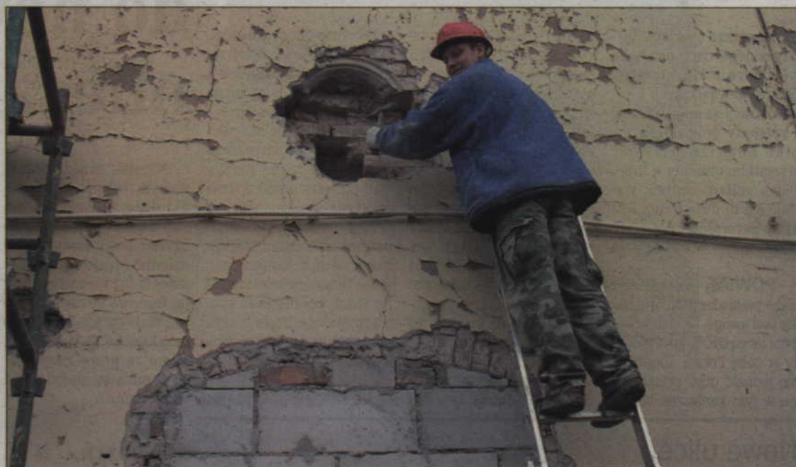
Podczas remontu budynku przy ul. Malborskiej natrafiono na elementy architektoniczne, które przez wiele lat skrywały tynki. Na zdjęciu: Robert Kamiński, który pracuje przy remoncie budynku Domu Pomocy Społecznej.
