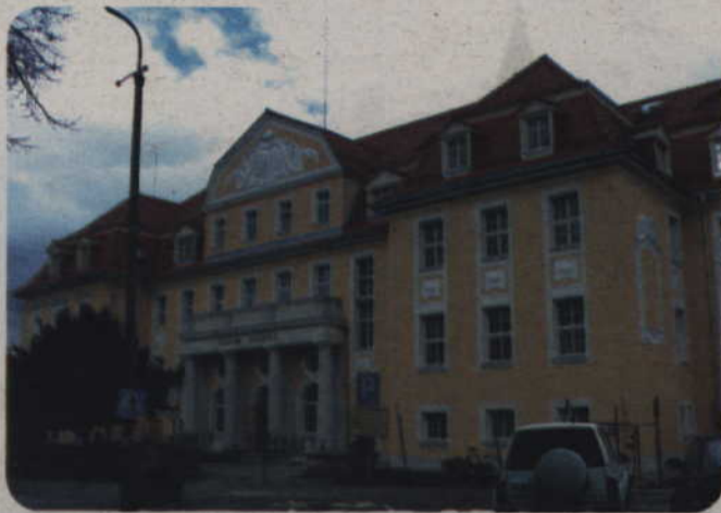
Zakończono już wszystkie prace budowlane i instalacyjne w gmachu Urzędu Miejskiego w Kwidzynie. Odbyły się też odbiory techniczne.
