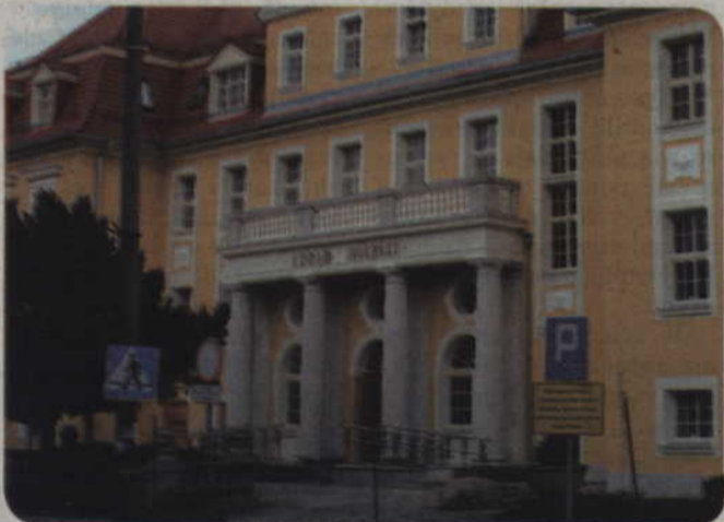
Tylko brak mebli jest przeszkodą w przeprowadze do wyremontowanego budynku.
