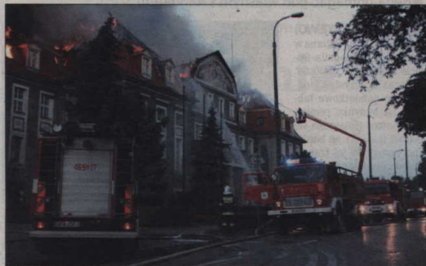
Pożar, który wybuchł 23 września 2007 roku, strawił dach i poddasze zabytkowego gmachu.
