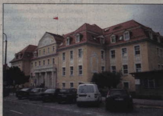
Wyremontowany budynek urzędu także z zewnątrz wygląda efektownie.
