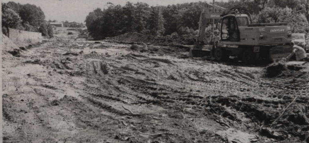
Radni gminy Kwidzyn i rolnicy będą domagać się od Zarządu Dróg Wojewódzkich przesunięcia terminu remontu mostu. - Prace mogłyby zostać wykonane po zakończeniu żniw, tym bardziej, że zamknięta jest także droga przez Dankowo z powodu budowy małej obwodnicy - przekonują.
