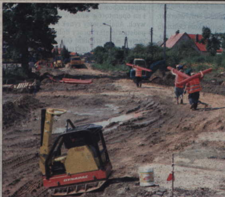
Rozpoczyna się budowa małej obwodnicy, co uniemożliwia zorganizowanie objazdu przez Dankowo - jest to konieczne, bo w tym samym czasie rozpoczęto remont mostu w Górkach na trasie Kwidzyn - Prabuty.
