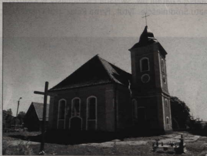
Barokowy kościół p.w. św. Anny w Gdakowie Dawny kościół ewangelicki obecnie parafialny rzymsko-katolicki. Wybudowany w latach 1753-1755 według planów mieszkającego w Gdakowie polskiego architekta Bogumiła Haselbachera. Wieża była naprawiana w 1796 roku i 1835.
