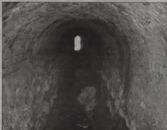
Zabytkowe Wodociągi z - XVIII w. Kanały wodociągowe zostały wybudowane w latach 1726-1730 w celu poprawy zaopatrzenia miasta w wodę. Doprowadzały wodę do 4 pomp rozmieszczonych w rogach rynku. Zbudowane zostały metodą odkrywkową na głębokości 3,5 metra pod rynkiem miejskim. Mają z grubsza kształt dużej litery F. Składają się z kanału głównego długości 119 m, odnogi wschodniej o długości 45 m. i odnogi zachodniej o długości 42 m.
