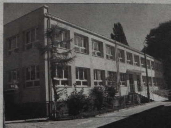
Przedszkole nr 4 po wakacyjnym remoncie.
