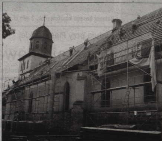
Remont kościoła w Obrzynowie kosztować będzie prawie 269 tys. zł.
