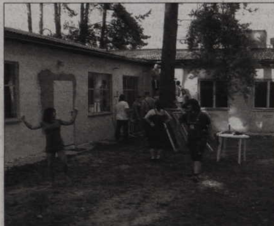
Głównym zadaniem młodzieży było przeprowadzenie remontu ośrodka wypoczynkowego w Orkuszu.
