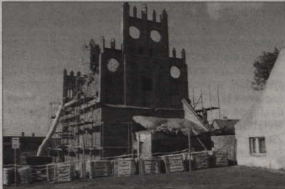
Kościół remontowany jest ściśle według zaleceń konserwatora zabytków.
