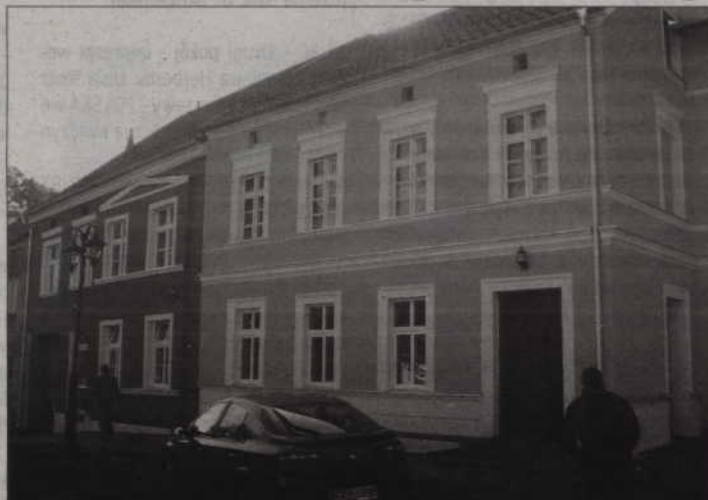
Remont objął też wymianę pokrycia dachu i wymianę drzwi wejściowych.
