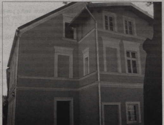
W budynkach przy ul. Warszawskiej odnowiono m.in. elewację.
