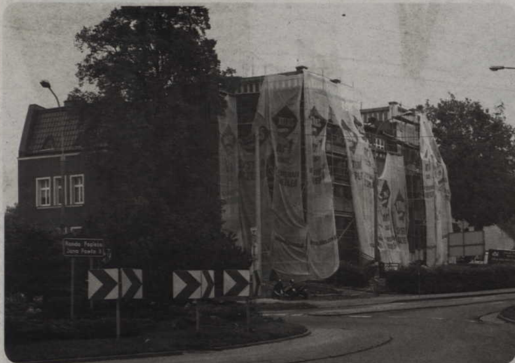
Dobiegają końca tegoroczne remonty kamienic. Wszystkie prace powinny zakończyć się w ustalonych z wykonawcami terminach.
