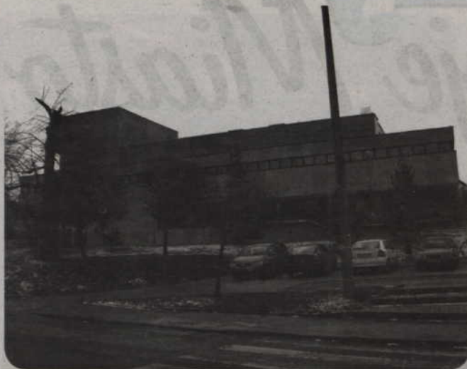
Dobiega końca remont teatru. Wyremontowane będzie zaplecze. Zainstalowana zostanie także winda.
