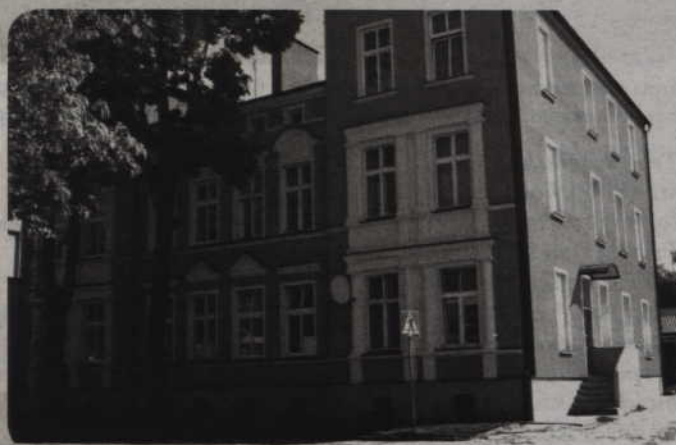
Jedną z remontowanych w tym roku jest kamienica przy rondzie Jana Pawła II. Budynek należy do wspólnoty mieszkaniowej.
