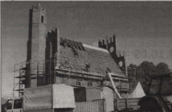
Na zabytkowym budynku położony zostanie nowy dach.
