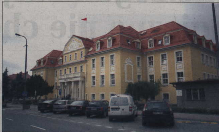
Starostwo powiatowe i Urząd Miejski w Kwidzynie połączy światłowód. Rozpoczęto jego układanie. To początek realizacji projektu, którego celem będzie stworzenie systemu informacji przestrzennej.
