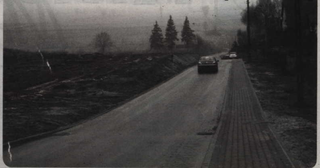
Na ul. Karowej wykonano nawierzchnię oraz chodnik.
