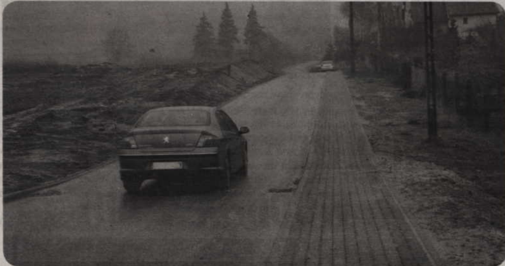
Kontynuowana będzie rozbudowa systemu kanalizacji sanitarnej i deszczowej oraz sieci wodociągowej w Kwidzynie. W ubiegłym roku skanalizowane zostały między innymi ulice Karowa i Przyrzeczna.
